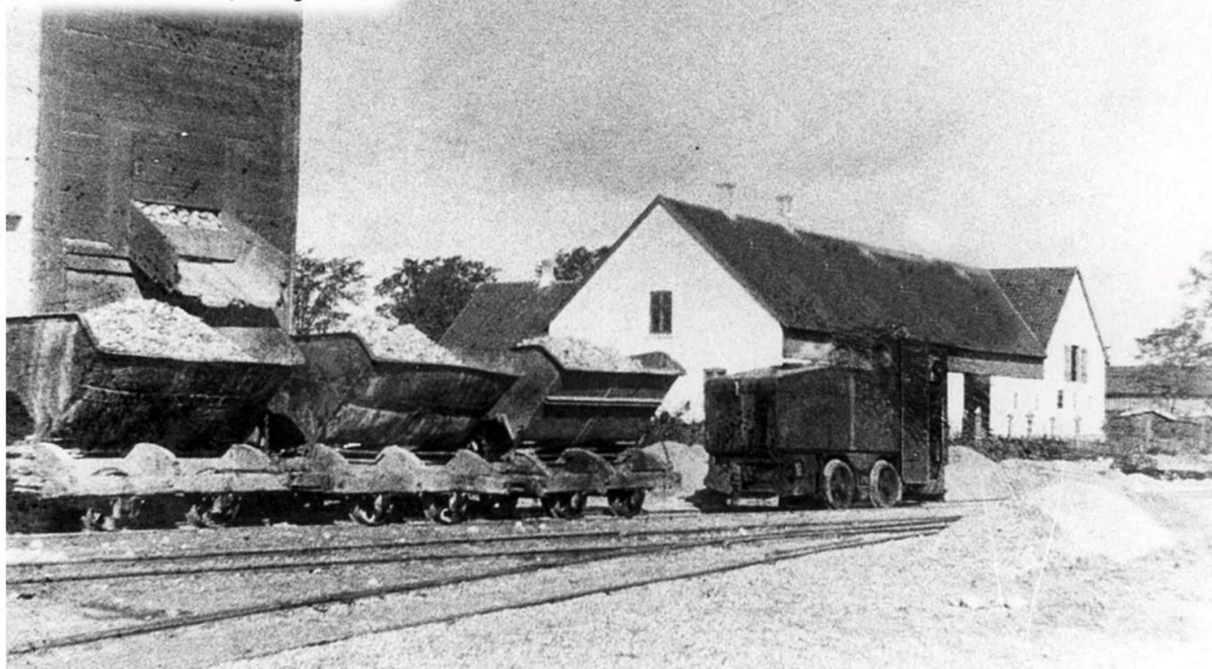
Benzollokomotivet ved sorteringsværket i 1928 med Nymøllegård i baggrunden.
